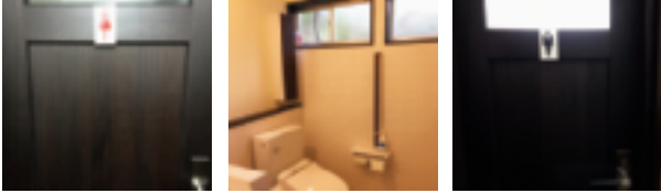
法人会館内のトイレが完成！（1F 女性用、2F 男性用）
